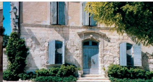
Façade à Velleron
